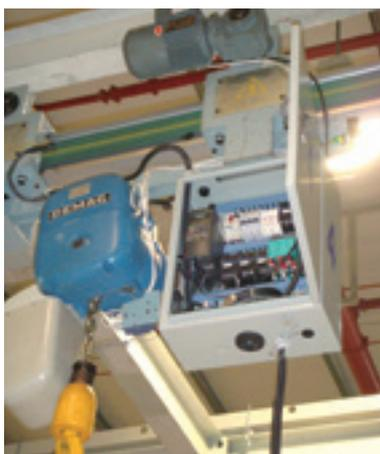
在欧宝的新工厂生产线中，将AS-Interface集成到悬挂或地面输送系统。通过滑触线建立AS-i总线系统。自动编地址，并将AS-i模块传送给生产线上的下一个AS-i主控机。用这种方法，一个连续的AS-i总线长度可达一公里。集成于AS-i总线的编码器用来控制悬挂小车的高度。应用AS-i总线后，极大地减少了工作量，加速了系统速度。简单的、效费比高的分布式控制成为可能。EMC问题不会影响坚固的AS-i总线系统。
